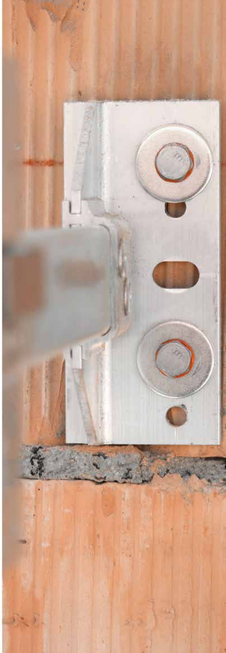
Конический бортик обеспечивает контролируемую глубину установки.
